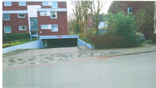
Bild Nr. 4 Seiffertstraße, Tiefgaragenauffahrt + Straßenparkfläche neben dem Endreihenhaus Nr. 75
